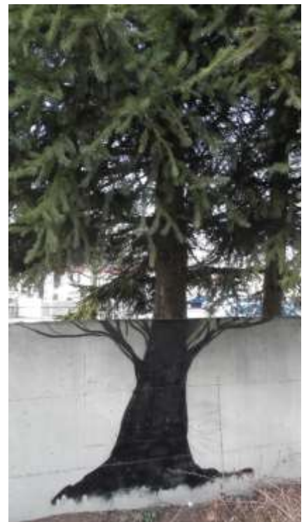
Mauer im Dr.-Geiger-Weg
